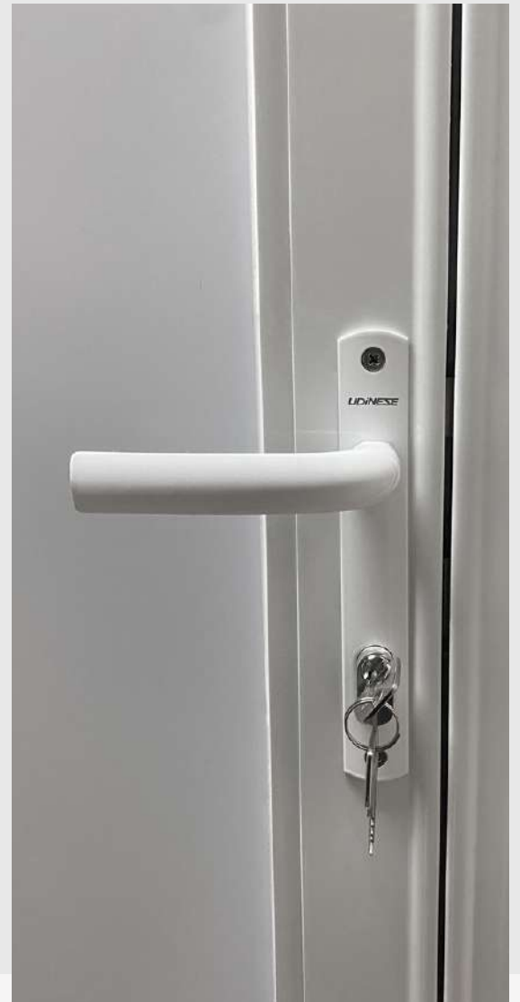
Cerradura con manija contravidrios perimetrales
